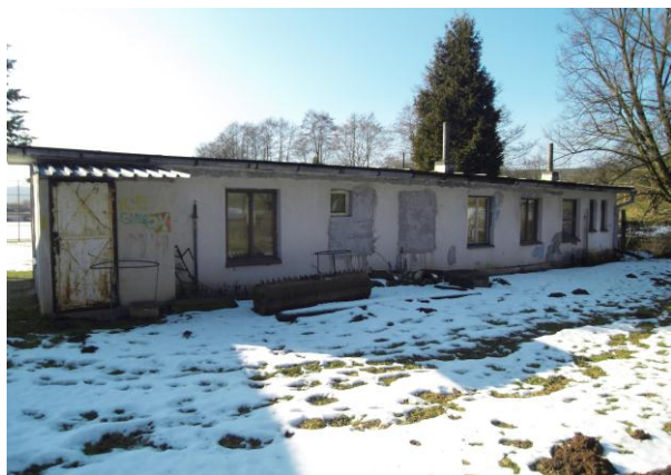
Rekonstrukce oken a dveří fotbalových šaten
