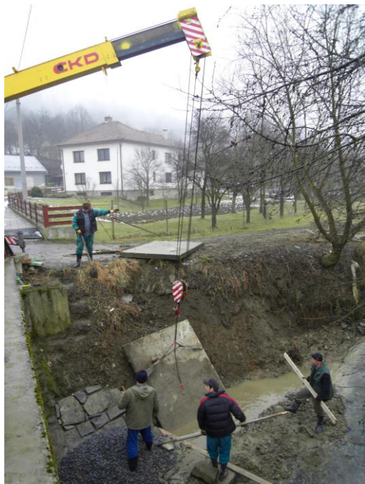
Oprava mostu v Drnovicích
